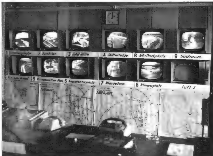
Bild 5. Blick auf einen Teil der Monitore in der Polizeizentrale Halle 12. Der Hubschrauber befand sich zum Zeitpunkt der Aufnahme nicht in der Luft, daher war der zugehörige Monitor Luft I außer Betrieb
