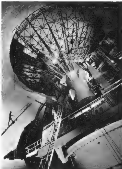
Im oberbayerischen Raisting geht die erste deutsche Satellitenfunk-Bodenstation ihrer Fertigstellung entgegen. Unser Bild zeigt einen Blick in das Innere der großen Rundhalle (Radome) mit der Antennenanlage in einem bereits weit fortgeschrittenen Stadium ihres Aufbaus
